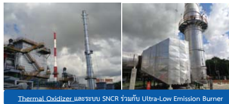
Thermal Oxidizer และระบบ SNCR ร่วมกับ Ultra-Low Emission Burner
